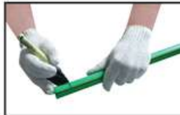
2. Beri tanda batas masuk ke dalam pipa
