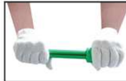
4. Setelah selesai dipanaskan, sambungkan pipa dengan fitting.
