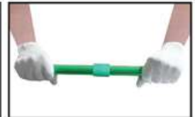
5. Pendinginan dilakukan sesuai standar waktu, sambungan akan terpasang sempurna.
